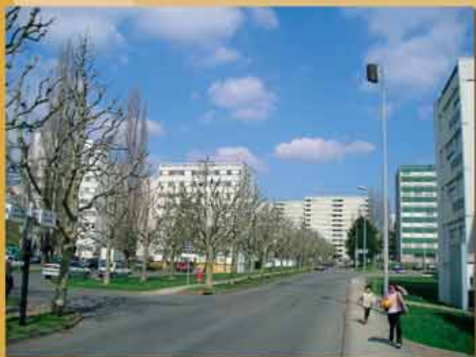
Rue de Cologne Date de construction : 1970. Photo A. Gagnieux, 2004
