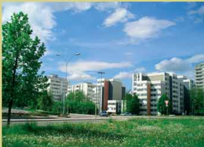
Rue des Causses Date de construction : 1977. Photo A. Gagnieux, 2004
