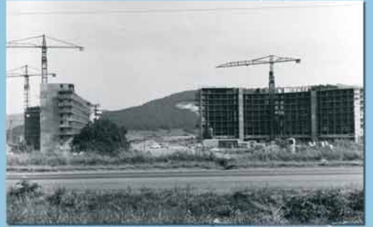
Depuis la rue de Dole : la future rue de Picardie ; à droite, l'avenue de Bourgogne, 25 avril 1967.
